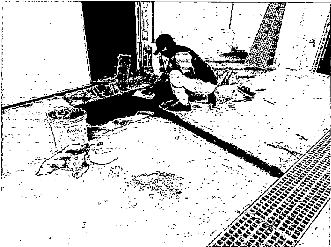
Fotografía N°09: Vista de personal operario realizando instalación de rejilla frente a cámara frigorífica de 5 ton.
