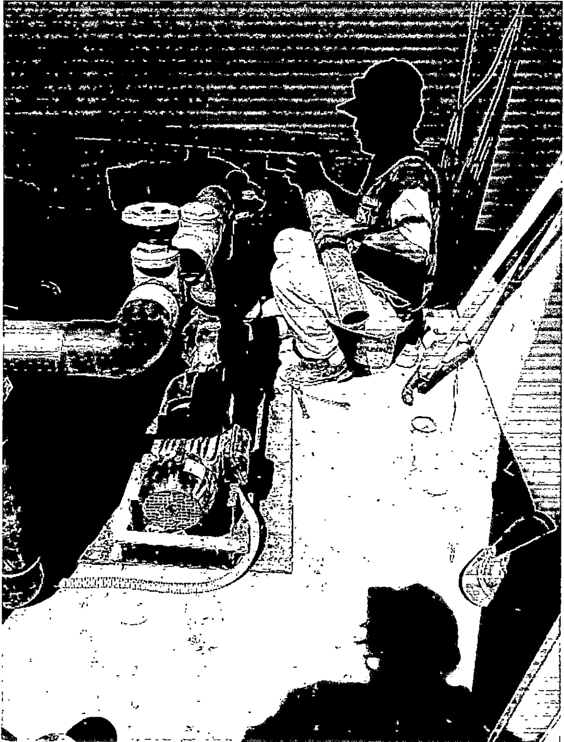
Fotografía N°26: Vista de operario desmontando árbol hidráulico de cuarto de bombas en emisor submarino por no cumplir con la especificación.
