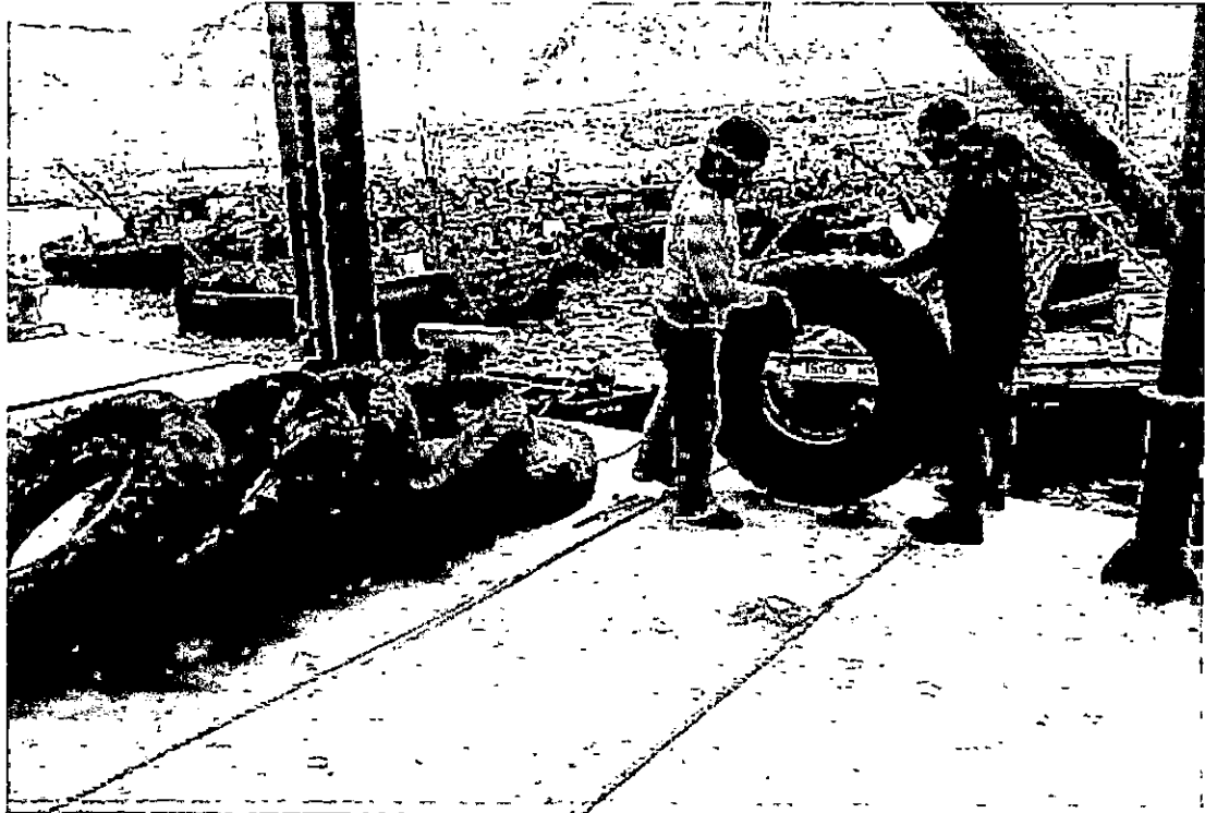
Fotografía N°08: Vista de colocación de llantas para defensa de muelles.
