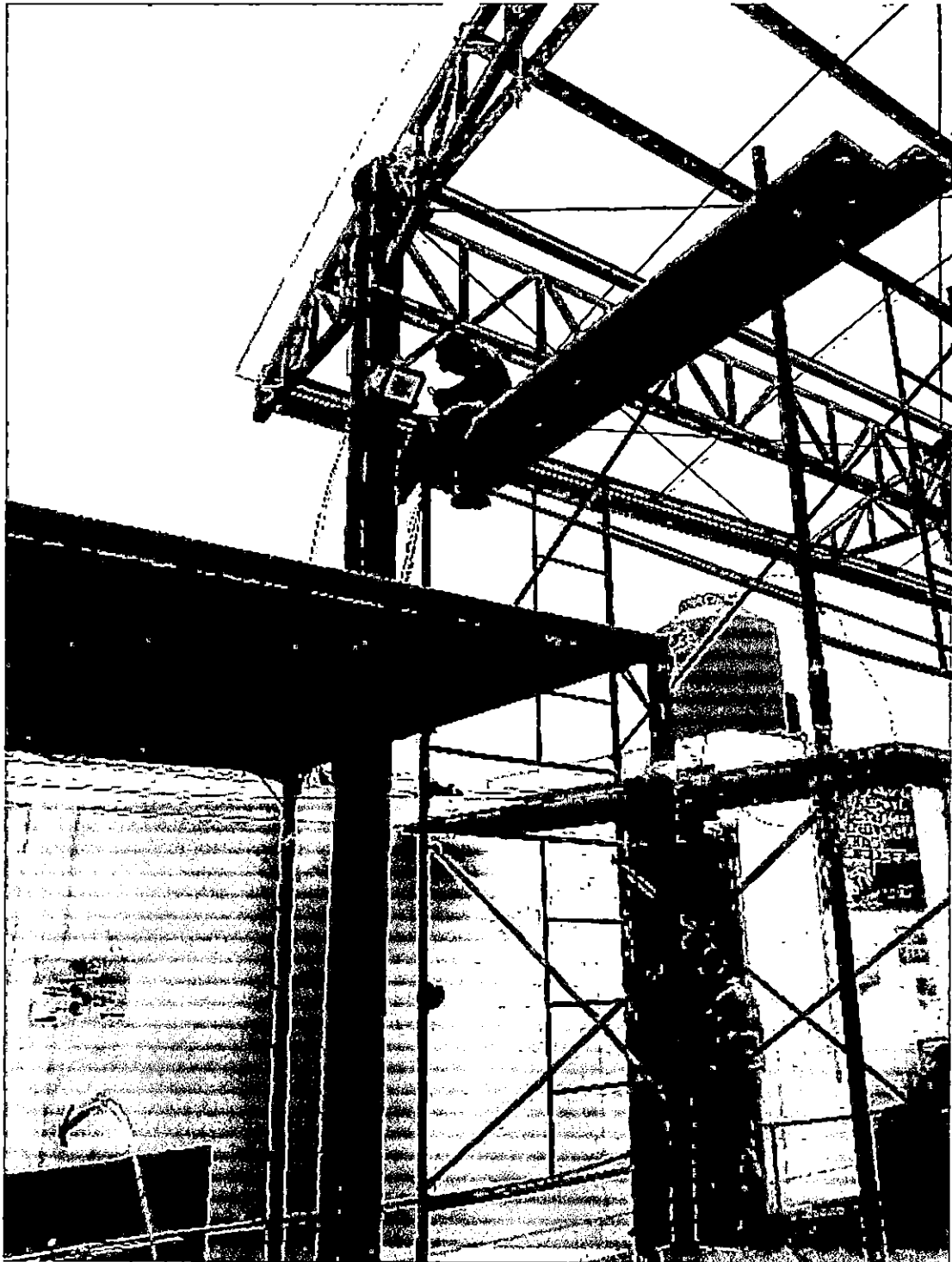
Fotografía N°10: Vista de personal operario colocando cables para iluminación de muelles.
